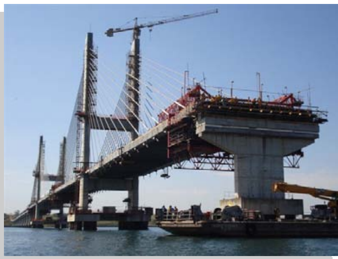
Ponte sobre o Rio Paraná: reforço do tabuleiro nos vãos centrais da ponte.
