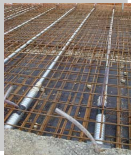
Ponte sobre o Rio Paraná: reforço do tabuleiro nos vãos centrais da ponte.
